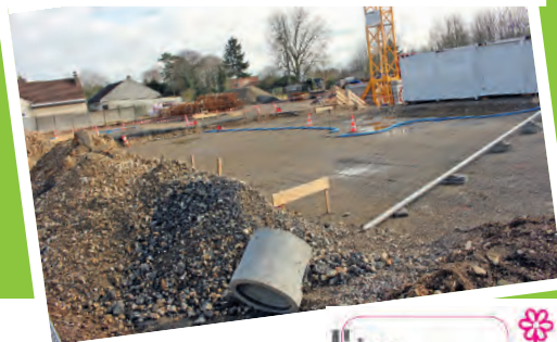
18 appartements et 7 pavillons vont sortir de terre.
