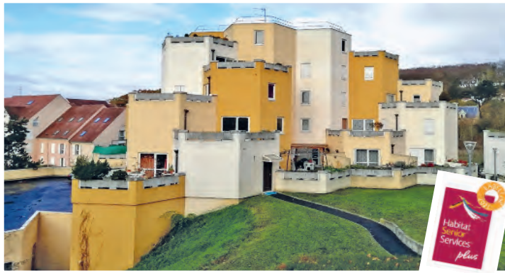
33 logements vont être dotés d'équipements adaptés à des locataires seniors, conformément au label Habitat Senior Services®
