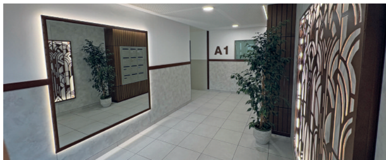
Fin de chantier aux Tilleuls.
